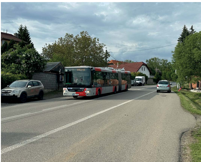
Chodník po levé straně (směrem do obce), dvě moderní autobusové zastávky a přechod se středovým ostrůvkem na Ládví-Kuklíku
