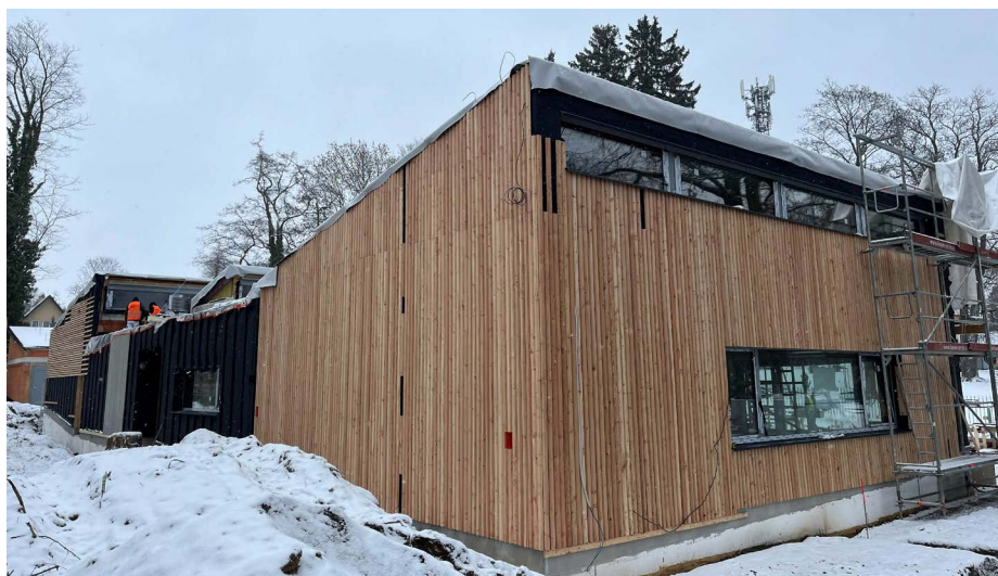
Na západní straně budovy je již hotová finální fasáda.
