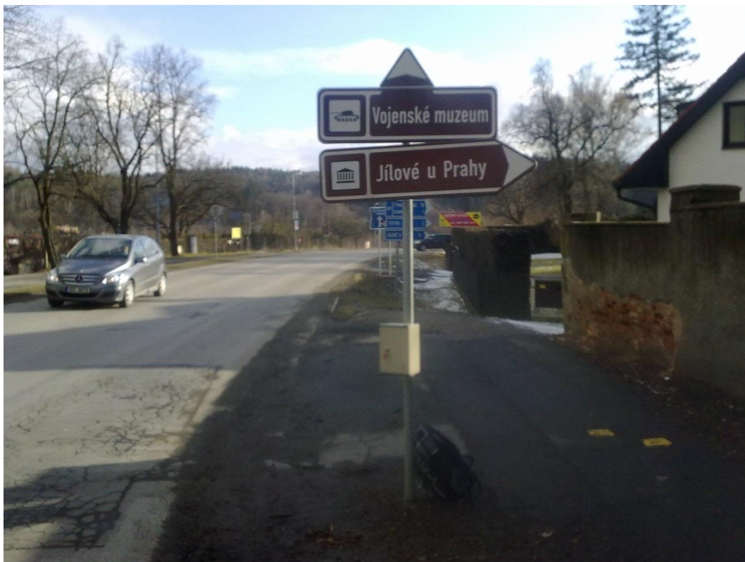
Silnice II/603 v blízkosti křižovatky ulic Benešovské a Ringhofferovy (II/603 a II/107) - pohled směr Benešov
