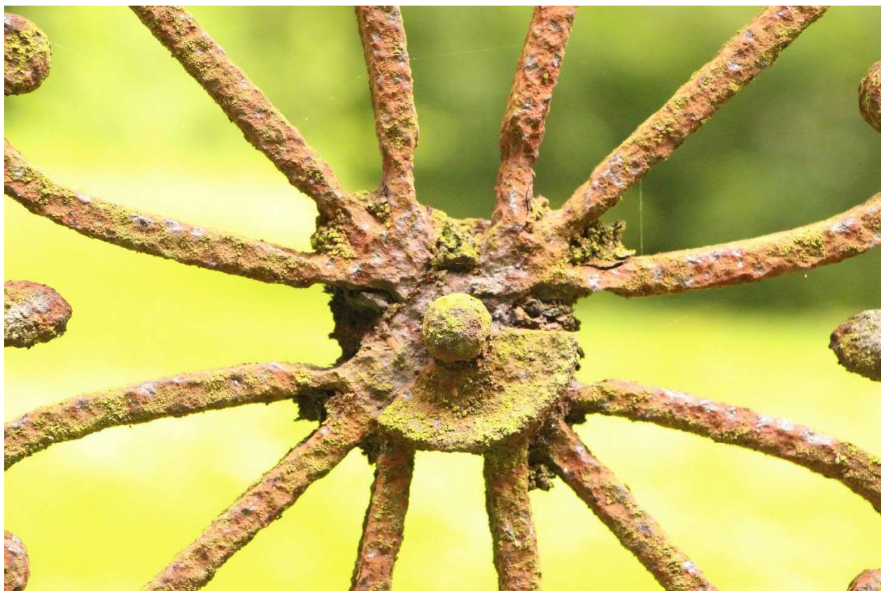
Detail zeslabení středu maltéžského kříže, litinový kroužek z části chybí.
