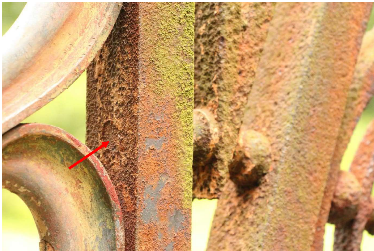
Detail nýťovaného spoje
