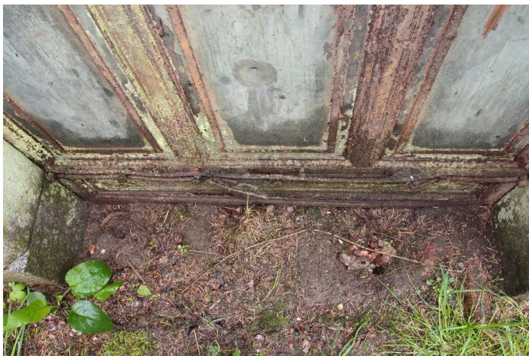
Detail poškození branky ve spodní části
