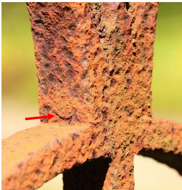
Detail nýtovaného spoje oblouků se svislou tyčí
