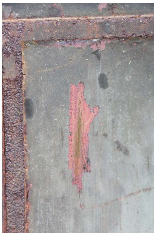
Detail ocelového rámečku na měděném plechu
