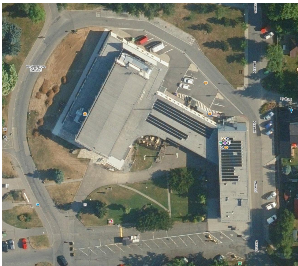
Obrázek 11 – Objekt Obecní úřad a Kulturní centrum s instalovanou fotovoltaickou elektrárnou (zdroj: https://mapy.cz )
