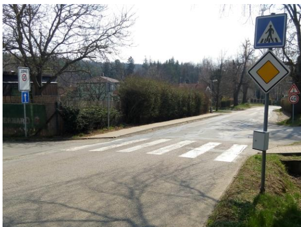
Obr. 29 Umístění radaru na průtahu II/107 v ulici Ringhofferova (pohled směrem na Těptín/Týnec nad Sázavou)
