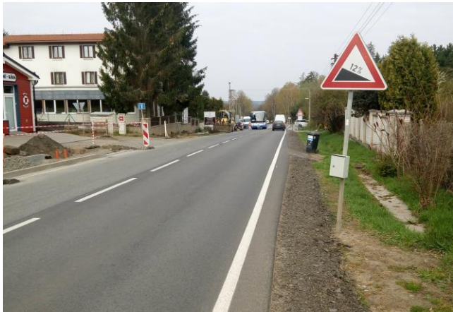
Obr. 10 Umístění radaru na II/603 (směr do Prahy)
