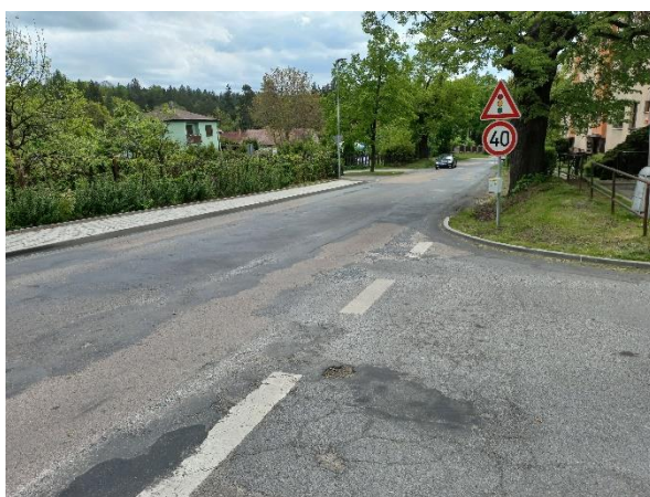
Obrázek 2.61: Umístění radaru na průtahu III/1052 (pohled směrem na Těptín).
