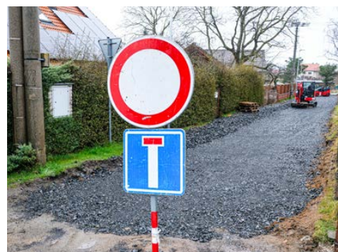
Topasová v Těptíně dostala nový povrch, osvětlení a odvodnění.
