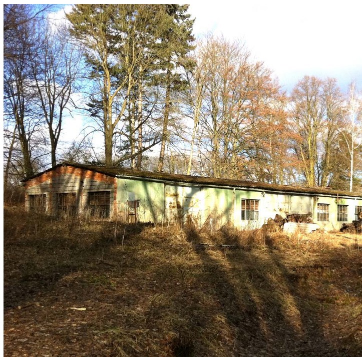
Pohled z jiného úhlu na území údajného parku s opuštěnou budovou truhlárny. I ta byla po koupi pozemku Strojmetalem odstraněna.
