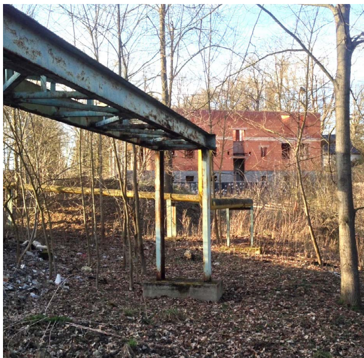
Stav území, které bylo v roce 2000 zakresleno jako parková zeleň. V pozadí černá stavba vily podnikatele, kterou Strojmetal odstranil.
