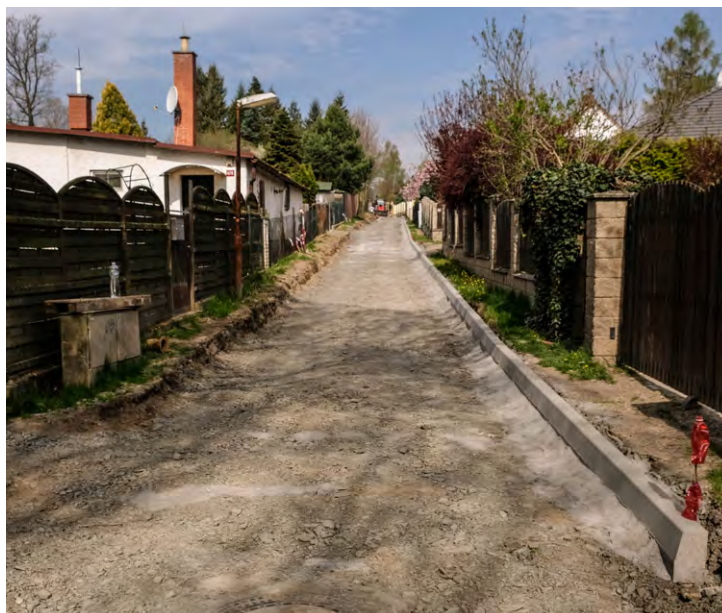
V ulici Slámová byly položeny kabely pro veřejné osvětlení a zároveň zpevněný povrch bývalé polní cesty. Vlevo fotka z března, vpravo stav ke konci dubna.
