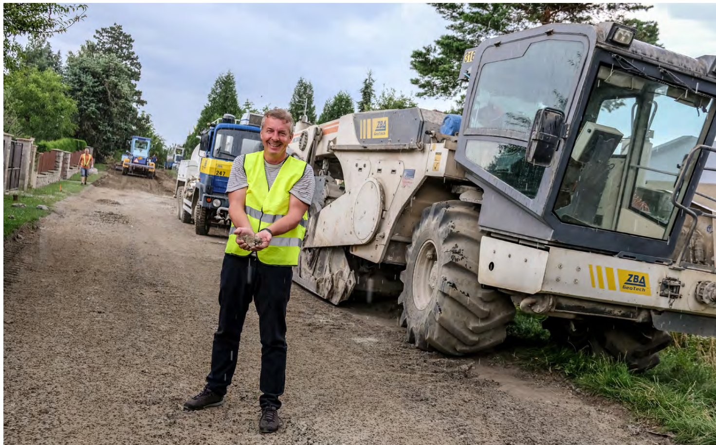
Starosta Pavel Čermák ukazuje drť, která se recykluje a slouží při stavbě nové silnice.
