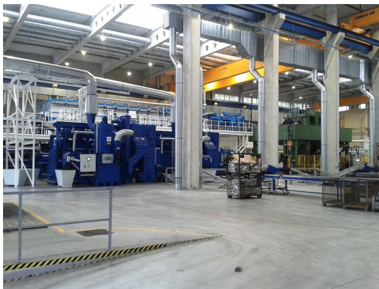
Obrázek 2 Interiér nové výrobní haly s automatickou kovací linkou
