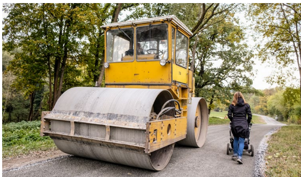
Válec dokončuje cestu v ulici Hamerská. Více informací v Rychlých zprávách na straně 7.
