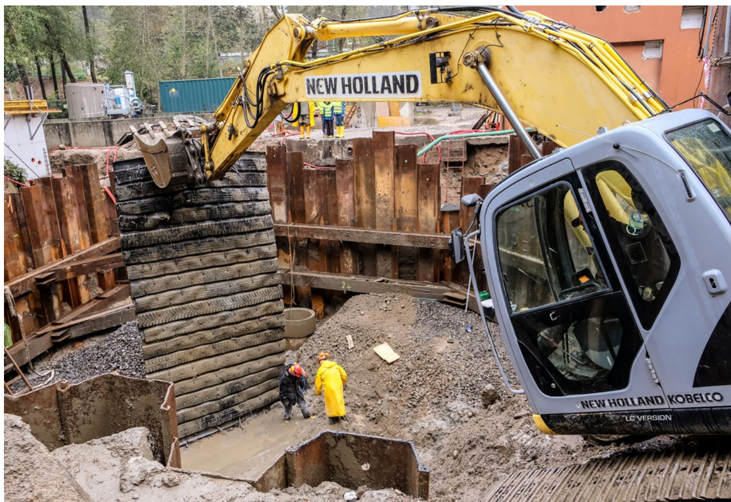
Nahoře: Celkový pohled na jámu, ve které bude umístěná nová dosazovací nádrž. Bagr zvedá bezpečnostní plachtu, aby mohli stavaři prozkoumat, co zbylo na místě obřího balvanu po výbuchu. Dole: Některé balvany, které se podařilo vytěžit bagrem, mají i deset tun.
