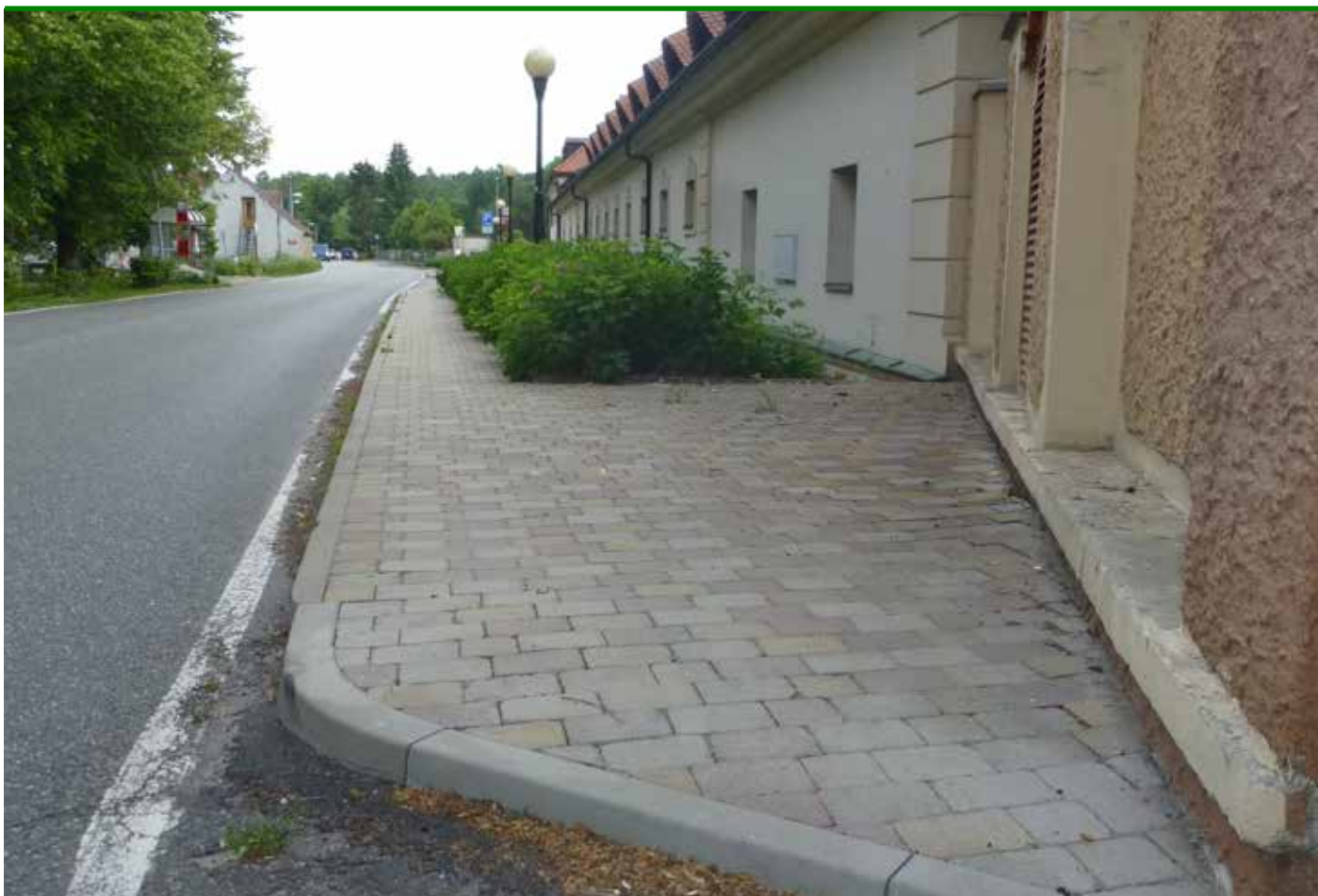
Opravený chodník podél zámku Štířín.
