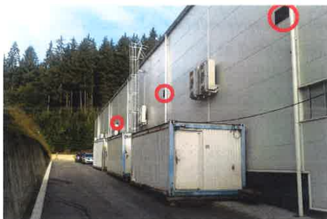
Obr. 4 – Výdechy linky 335 na jižní fasádě haly a výdechy technologie mořirny na střeše haly V2
