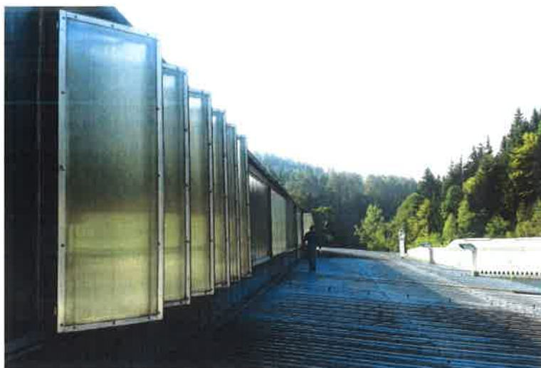
Obr. 3 – Otevřené prvky pultového střešního světlíku nové haly a výdech lisu linky 331 na střeše haly V1
