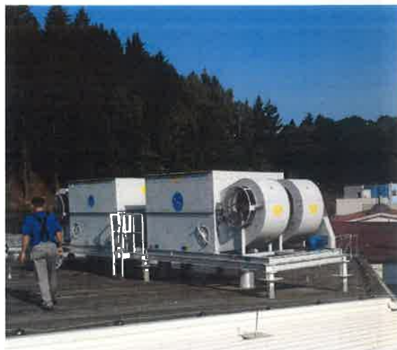
Obr. 5 – Chladiče vody Baltimor na střechách nové haly a haly linky 335
