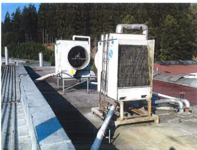
Obr. 5 – Chladiče vody Baltimor na střechách nové haly a haly linky 335
