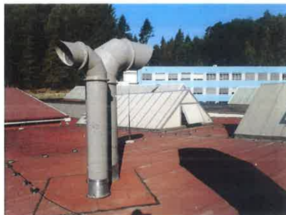
Obr. 4 – Výdechy linky 335 na jižní fasádě haly a výdechy technologie mořirny na střeše haly V2
