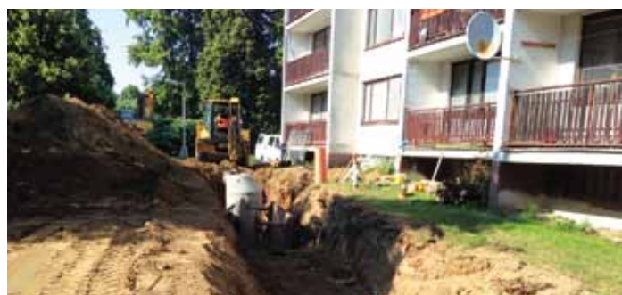
Oprava kanalizace Sídliště II.
