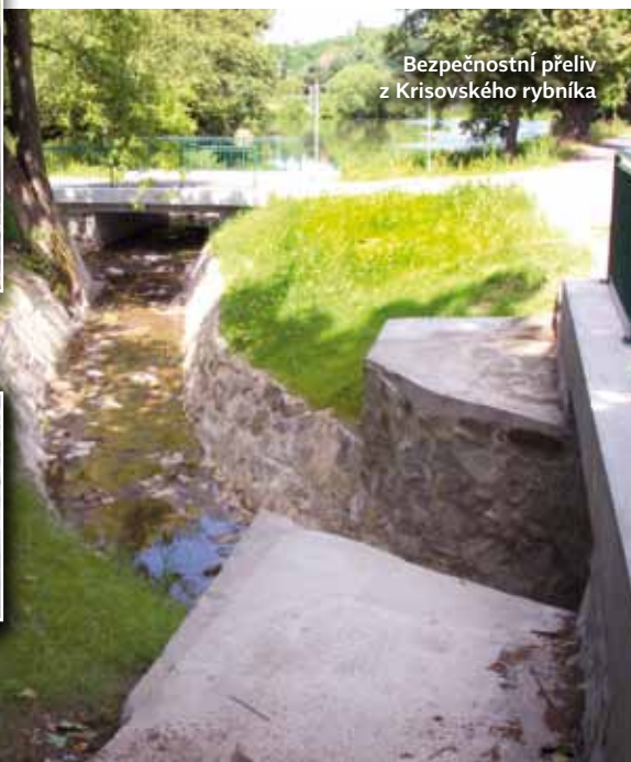
Můstek ulice Návrší a bezpečnostní přeliv Krisovský rybník – počátek rekonstrukce
