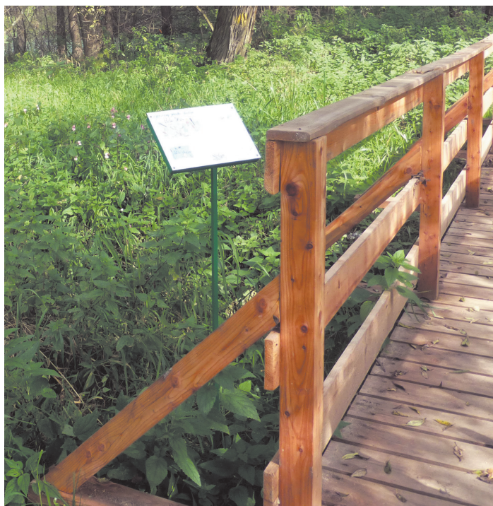
Nová cedulka byla umístěná u opraveného zábradlí.
