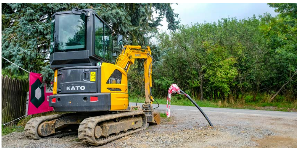
Stavba kanalizace ve Všedobrovicích.
