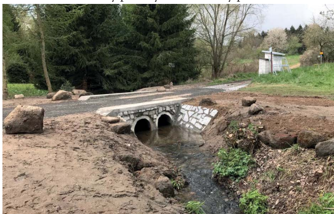
Obr č. 1 – Dokončená realizace propustku (chybí pouze zábradlí)
