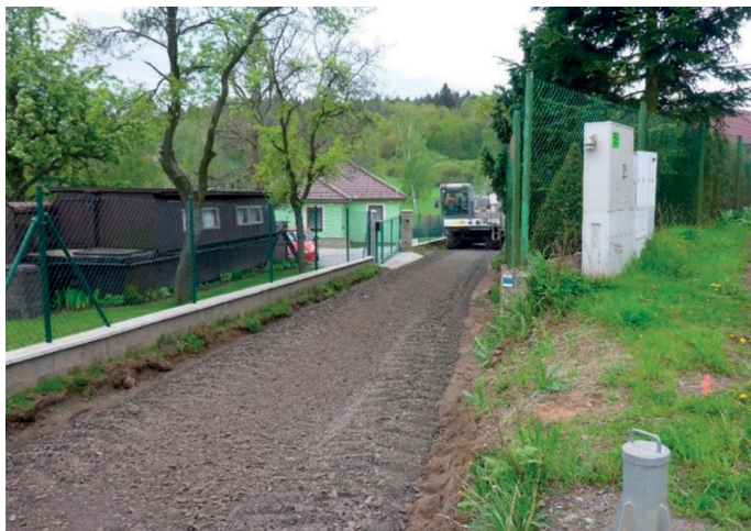
Obr č. 2 - Frézování asfaltových vrstev stávající vozovky
